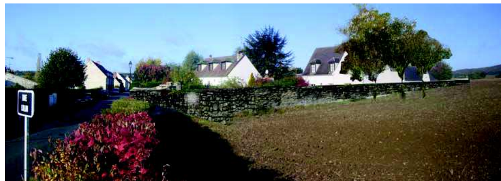
Limite construite existante avec une maçonnerie de pierre, appareillage à l'ancienne
