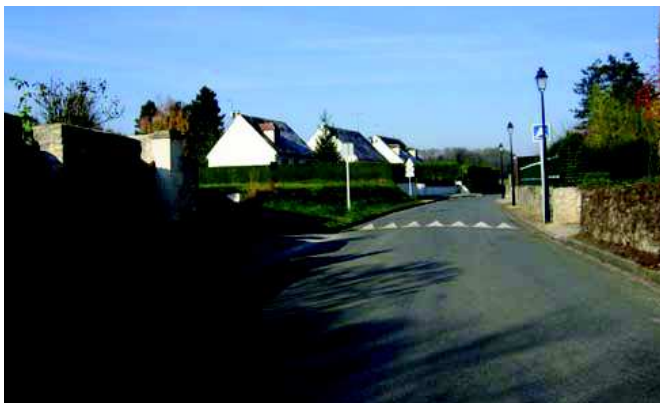
Rue de la République, pavillons en extrémité de village indifférents à l'espace public
